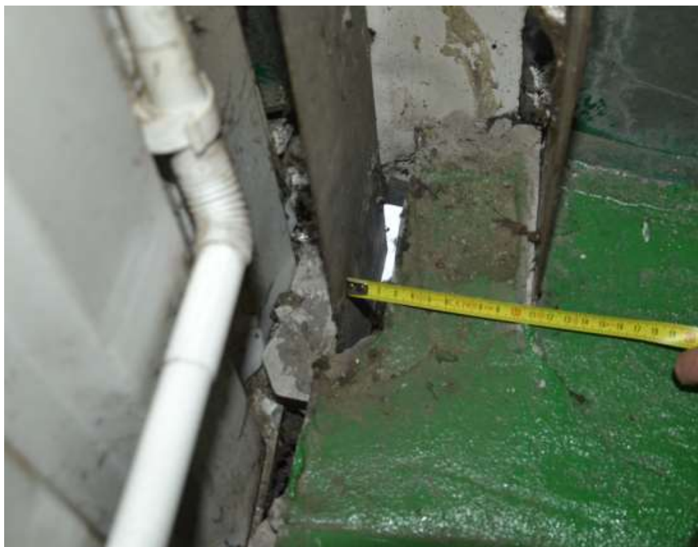
zabezpieczenie szczeliny w obudowie hali
