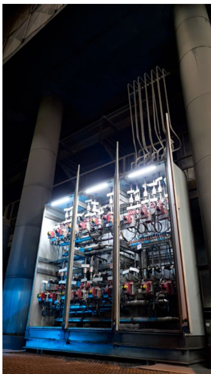
Przykładowa realizacja Technologii SNCR EESA – Instalacja do ograniczania emisji tlenków azotu (NOx) zabudowana na kotle w Elektrowni Rybnik – Sterowanie instalacją
