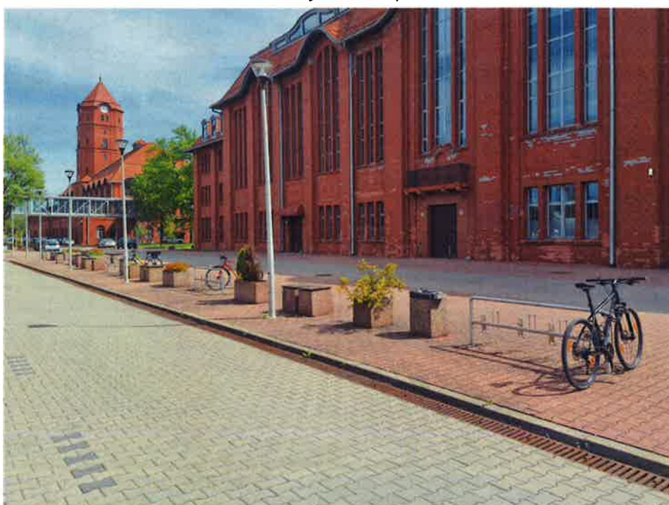
Fotografia 2 – Widok placów zewnętrznych (od strony zachodniej) przy budynku nr 4).
